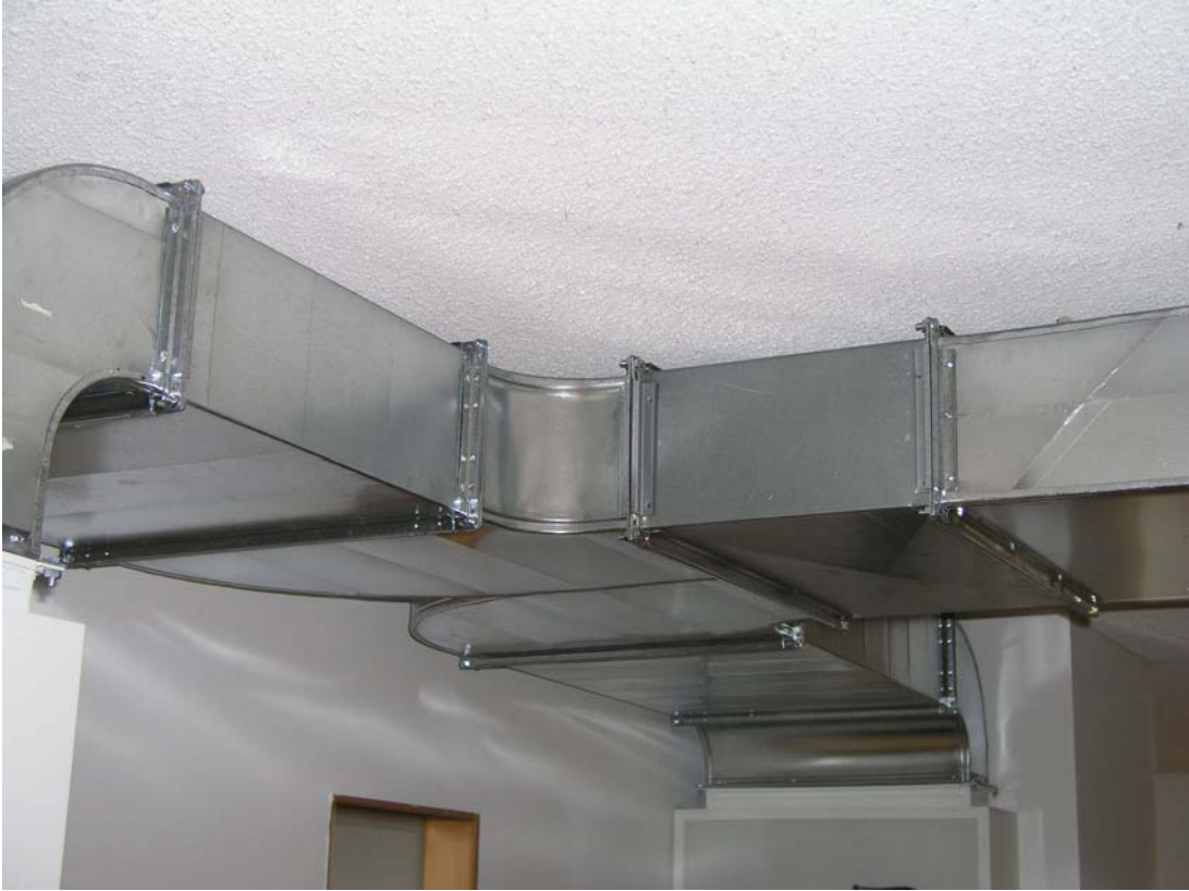
Zuluftkanäle und Abluft im großen Hörsaal
