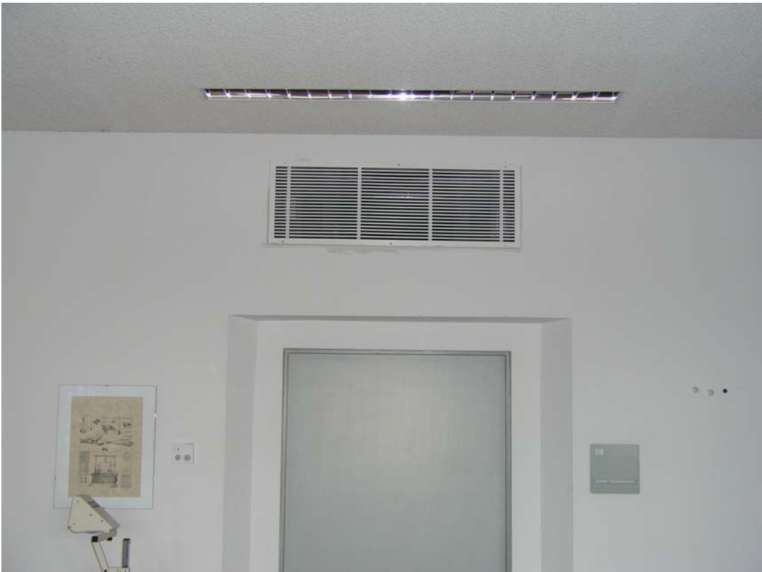
Zuluftkanäle und Abluft im großen Hörsaal
